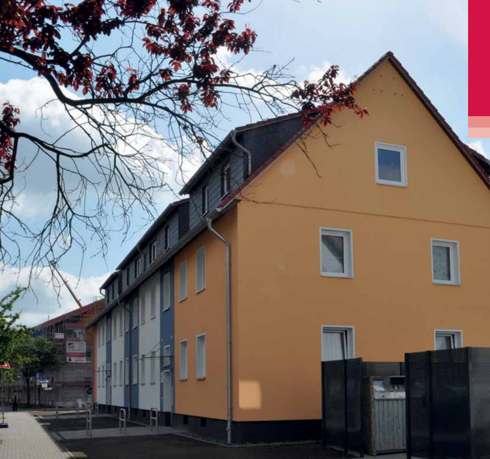
Dachgeschoss-Sanierung in der Herzog-Ernst-August Straße 6 - 8
