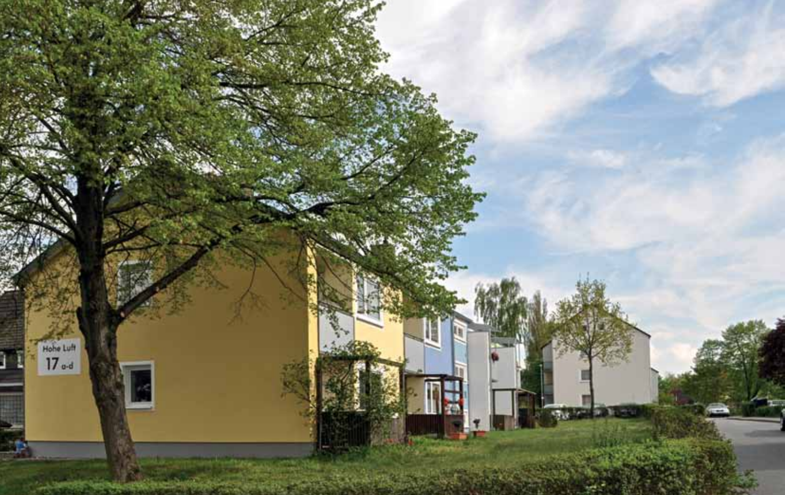
Hohe Luft 17: Sanierung der Fassade
