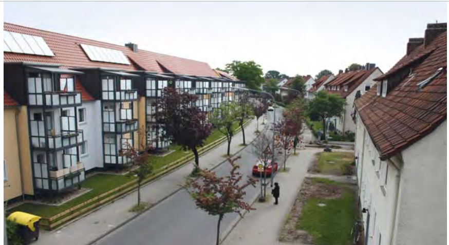
Herzog-Ernst-August-Straße: Sehen Sie den Unterschied? Links bestens modernisiert, rechts in Planung
