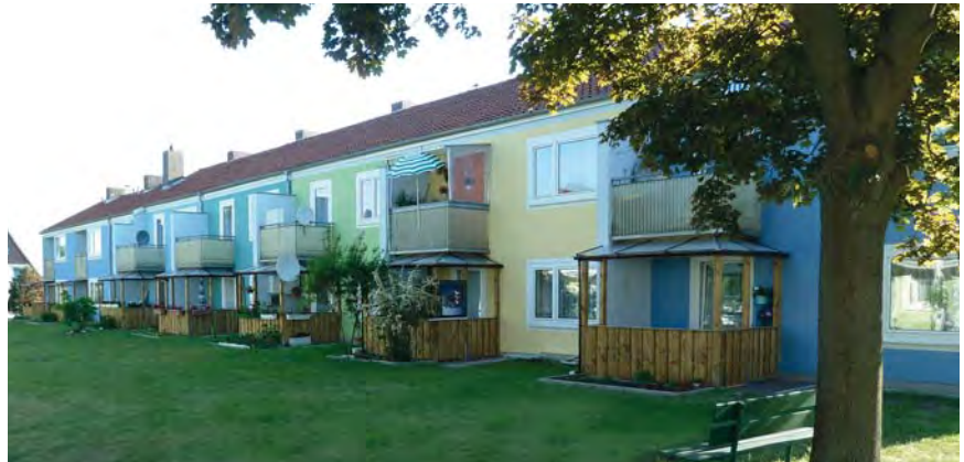
Steht vor umfassenden Umbauarbeiten: Wohnanlage Hohe Luft
