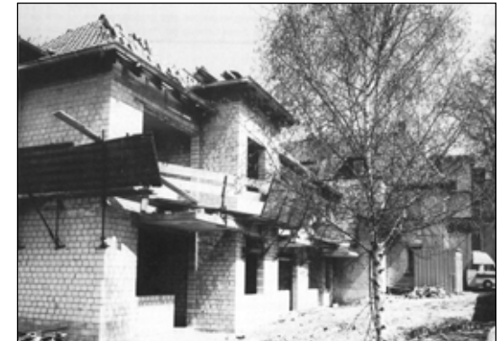
Auf der Hoffläche entstanden vorab sechs Seniorenwohnungen, in die die Mieter der Theodor-Menke-Stiftung untergebracht wurden, danach kam es zum Abriss des sogenannten Legathauses
