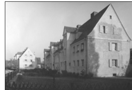
Das erste Bauvorhaben mit 42 Wohnungen am Kirchweg
