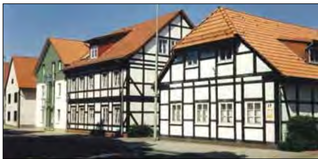
Die Sanierung des alten Ackerbürgerhauses Lühr in der Lindenstraße
