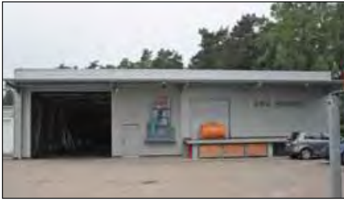
Der Regiebetrieb der GWG in der früheren Döpke-Halle
