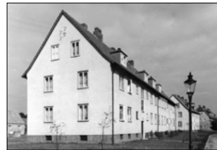
Die 50 Wohnungen am Ribbesbütteler Weg – im Hintergrund das sogenannte Weißwasserhaus
