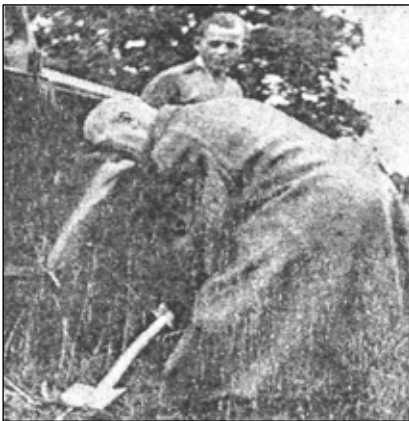
1949: Bürgermeister Scharpenberg beim ersten Spatenstich
