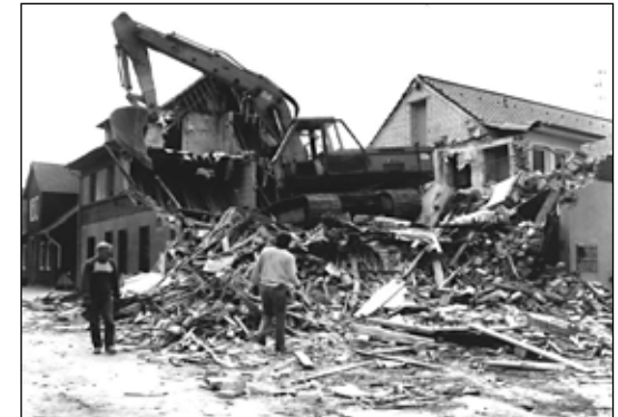
Der Abriss des Gebäudes, im Hintergrund die neu gebauten sechs Wohnungen
