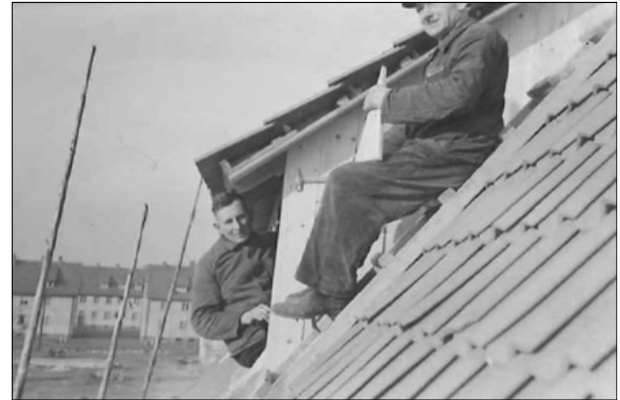
Wilhelm Köln (links) mit einem Arbeitskollegen bei Zimmererarbeiten am Erker des Geschäftshauses Herzog-Ernst-August-Straße 27
