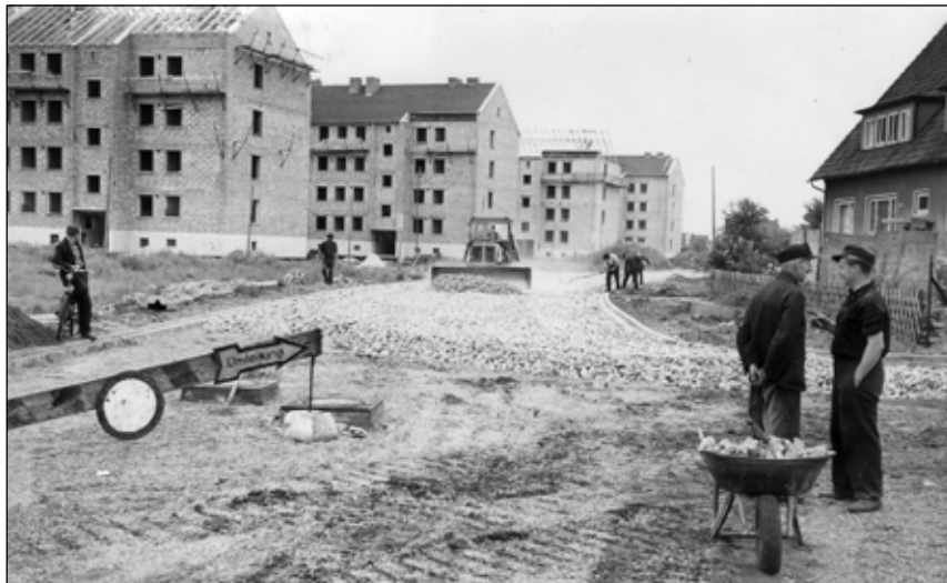
Der Alte Postweg im Bau, 1962
