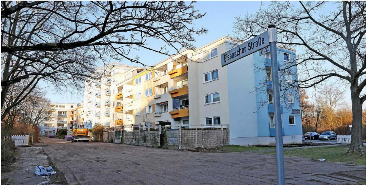
In der Eisenacher Straße in Wolfsburg-Westhagen laufen die Vorbereitungen auf die Sanierung großer Neuland-Wohnblöcke.
