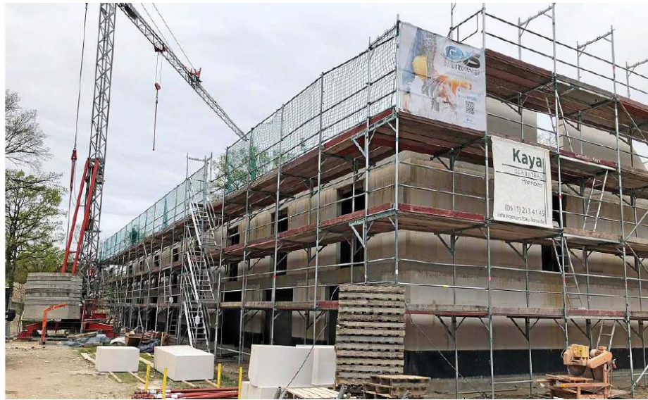
Für die ersten acht Reihenhäuser im Neubauquartier Hohe Düne wird das Richtfest im Mai gefeiert.
