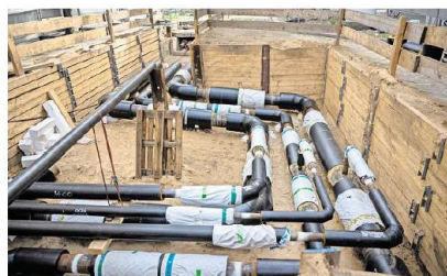
Rohre für Fernwärmeanschlüsse: Der Bund will bis 2045 rund 3,6 Millionen Wohngebäude an das Netz anschließen. FOTO: MONIKA SKOLIMOWSKA/DPA
