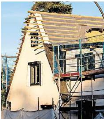
Vor allem Dächer werden oft saniert. FOTO: DANIEL BOCKWOLDT/DPA
