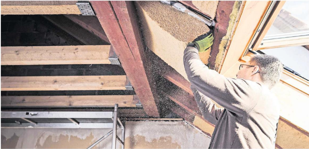
Ein Dach wird isoliert: Sanierungen können allerdings viel Geld kosten.
