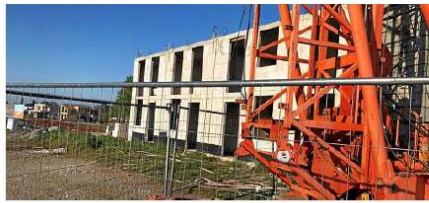
Seit dem Insolvenzantrag im Dezember hat sich an den Reihenhausbauarbeiten der Traumhaus AG im Gifhormer Baugebiet Hohes Feld nichts mehr getan.
