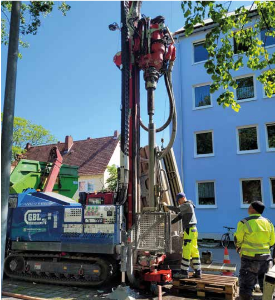
Bohrung für Erdwärme am Herbert-Trautmann-Platz
