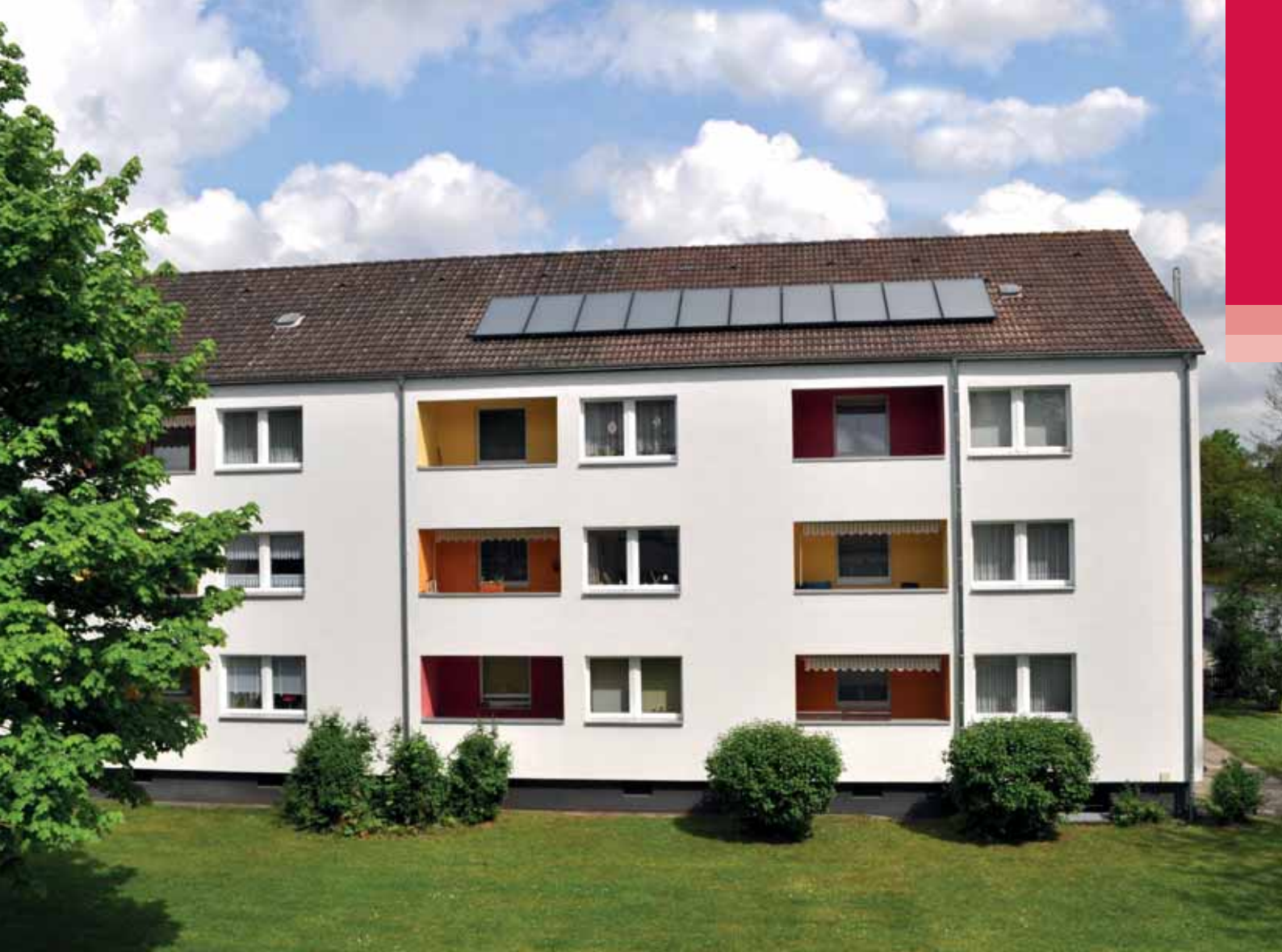
Solarkollektoren in der Borsigstraße
