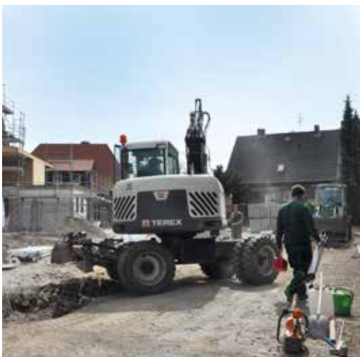
In der Außenanlage entstehen Einstellplätze.
