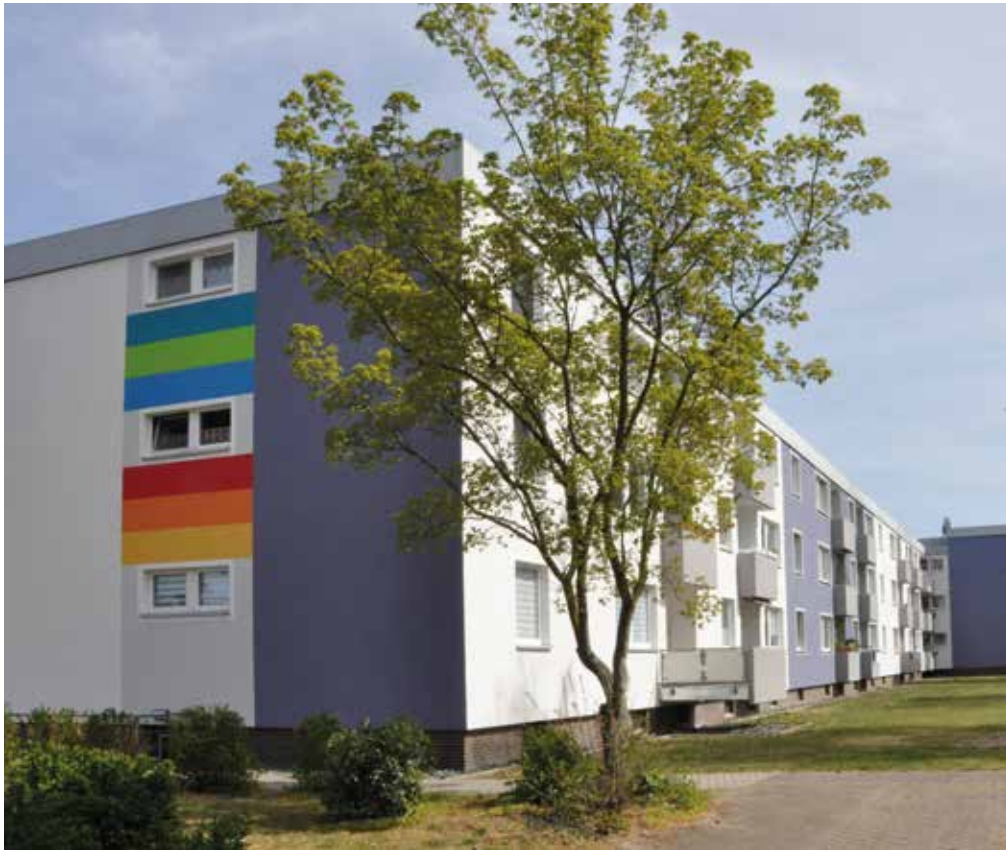
Sanierte Fassadenrückseiten in der Bäckersstraße
