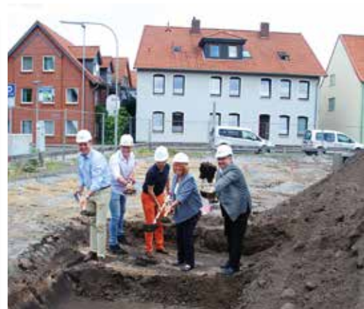
Der erste Spatenstich
