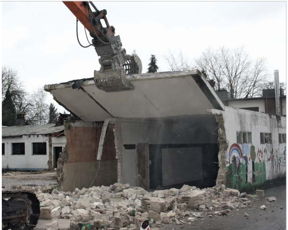
um dem ersten „Baggerbiss“ bei-zuwohnen. In den Wochen zuvor war das gesamte Gebäude komplett entkernt worden, so dass nun mit schwerem Gerät Wänden, Decken und Bodenplatten zu Leibe gerückt werden konnte.
